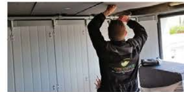
Brignoles : Isolation plafond de garage et sous sol à 1€ sans
